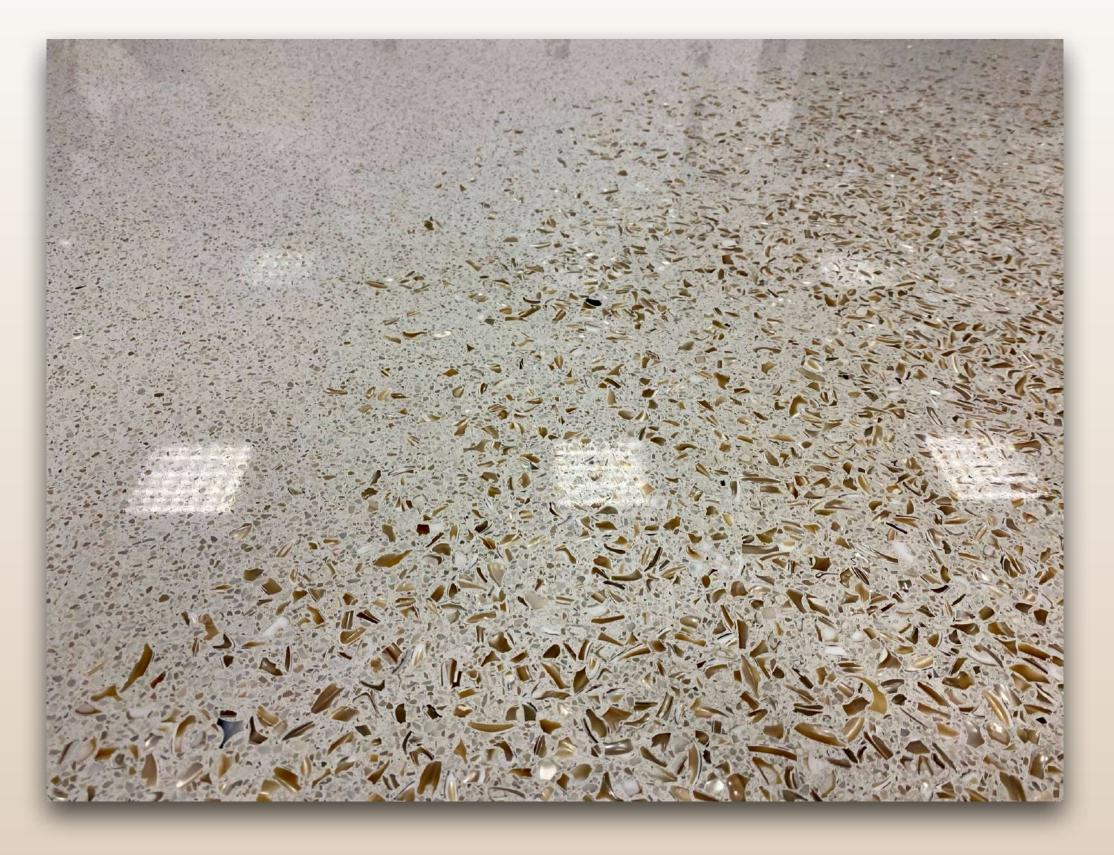
从我们的 SEAMLESS TERRAZZO 无缝地坪的无限变幻中获取灵感:从经典永恒的威尼斯水磨石地坪到摩登惊艳的现代水磨石,您有无尽的选择。我们的水泥基材料应用高科技,确保您可以自由选择单一或多尺寸骨料,使地坪优雅、无缝且不影响技术性能。
