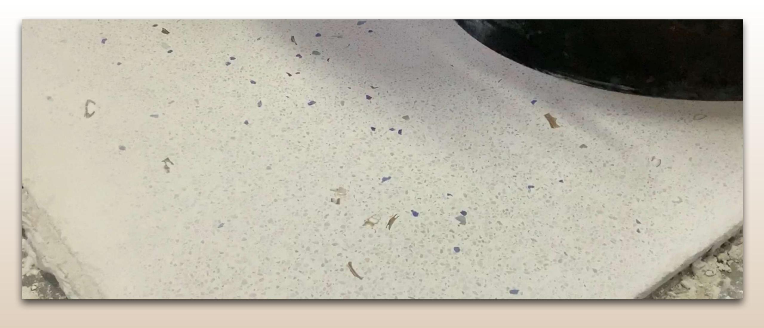
4到5人的团队即可保证每天完成至少600平方米(等于6500平方英尺)的12毫米(0.5英寸)厚的前期处理、搅拌和浇注,基础在研磨后10毫米(0.4英寸)厚即可。产品固化时间仅为24小时,因此,研磨后仅需稍作等待,即可看到漂亮的骨料和特色地坪从基层中呈现。这样独特、优雅、高性能、永不过时的地坪将为您的空间增光添彩。
