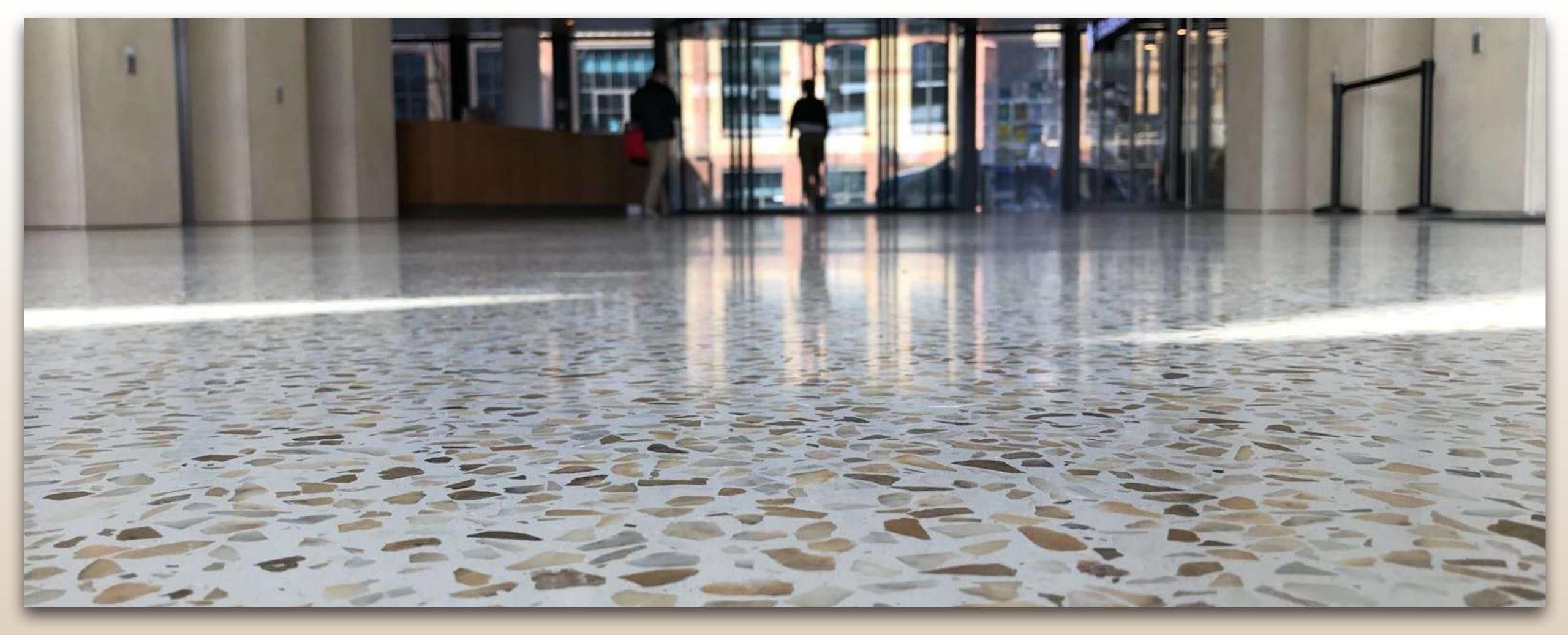
\*本产品可根据客户需求,仅使用大尺寸骨料,达到高雅大气地坪效果(传统水磨石地坪必须大小骨料混合掺杂) 双产品组成成份的矿物基砂浆,不含环氧树脂,可用于制作含小骨料或大尺寸骨料的均匀连贯地坪,研磨抛光后达到所需效果,没有任何缝隙和接缝!
