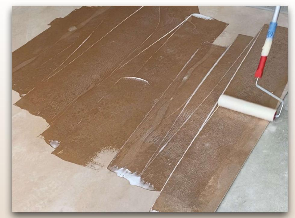
首先,在地面基层涂抹底漆,将 沙子或石英骨料浇在上面,安装 创造几何形状和颜色的型材。待 完全干透后,将AB材料混合, 浇至其面,形成完美贴合。
